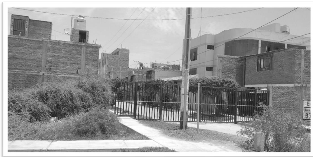
Figura 67: Rejas y cercos limitando accesibilidad a Urbanización La Pradera.
