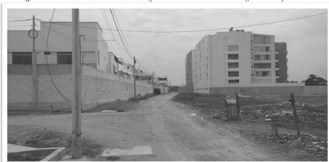
Figura 65: "Túnel" abierto muestra seguridad al condominio e inseguridad al peatón.
