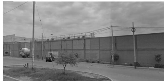
PLANTA CONCRETERA DINO
