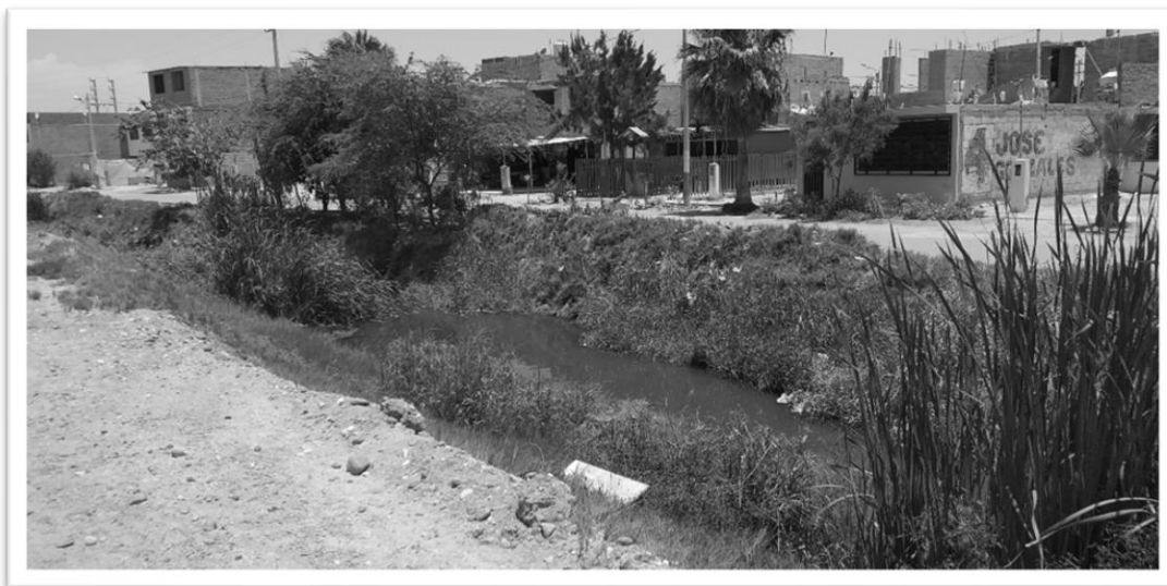
Figura 70: Dren 3100, atravesando Urb Las Dunas con aguas contaminantes.
